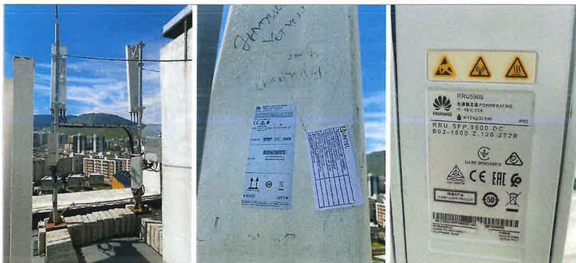
Зураг 3. Энхжин хотхоны 101 дүгээр байрны дээвэр дээр хэмжилт хийх үе.
