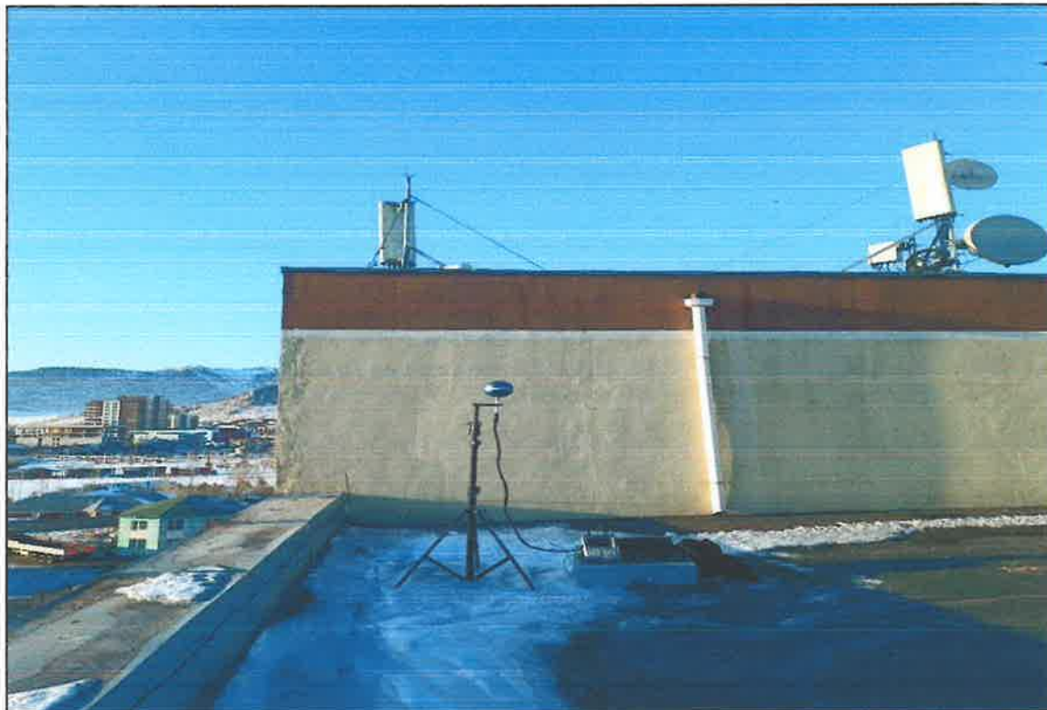
Зураг 2. 300 дугаар байрны дээвэрт хэмжилт хийх үе.
